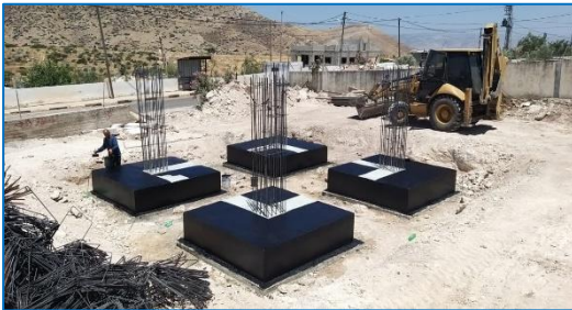
Al Aqaba Reservoir
